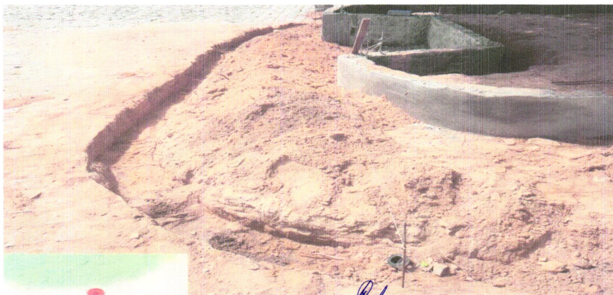
FOTO 02 - RETIRADA DE MEIO-FIO DNER / ECONOMICO COM EMPILHAMENTO E SEM BOTA FORA
