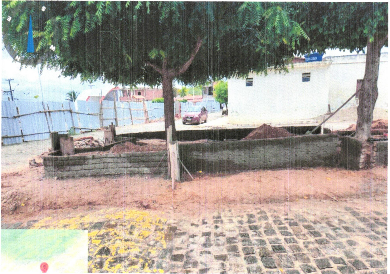
FOTO 12 - MASSA ÚNICA, PARA RECEBIMENTO DE PINTURA, EM ARGAMASSA TRAÇO 1:2:8, PREPARO MANUAL, APLICADA MANUALMENTE EM FACES INTERNAS DE PAREDES, ESPESSURA DE 10MM, COM EXECUÇÃO DE TALISCAS. AF_06/2014.
